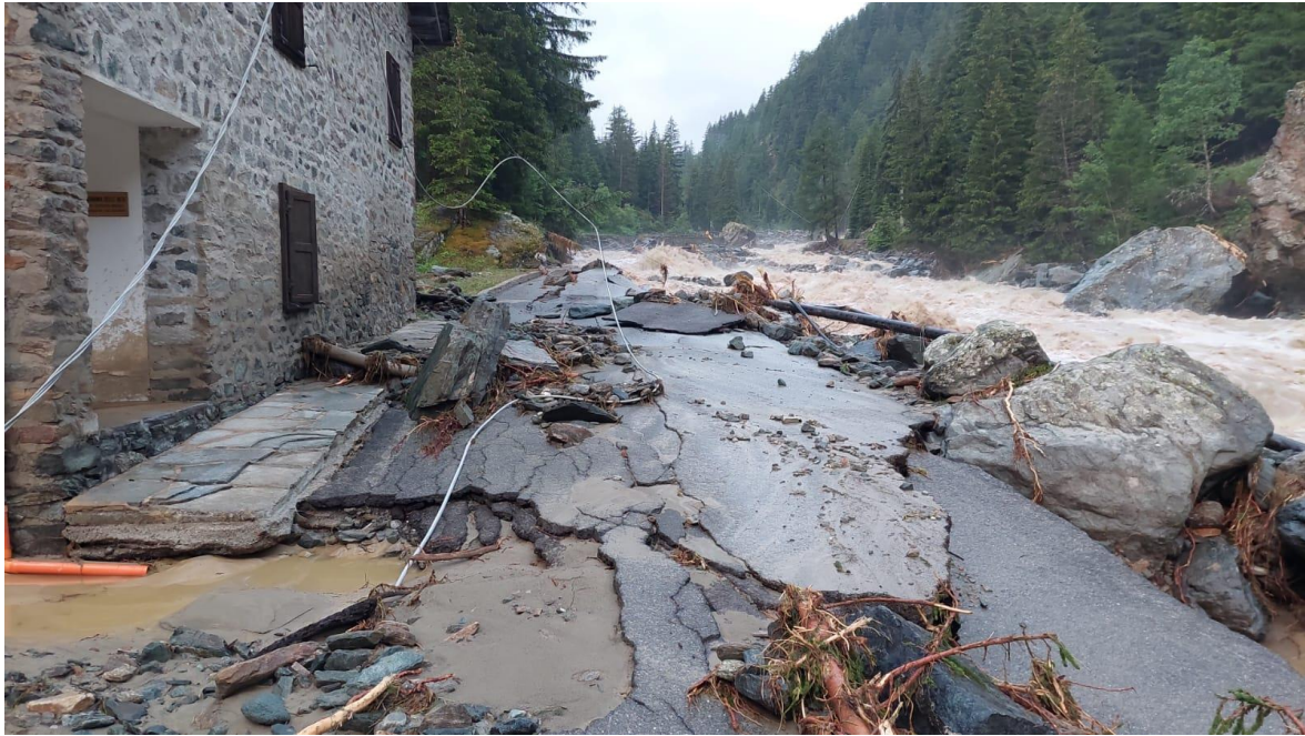
Erosione spondale del T. Valnontey con asportazione della strada nei pressi di un edificio.
