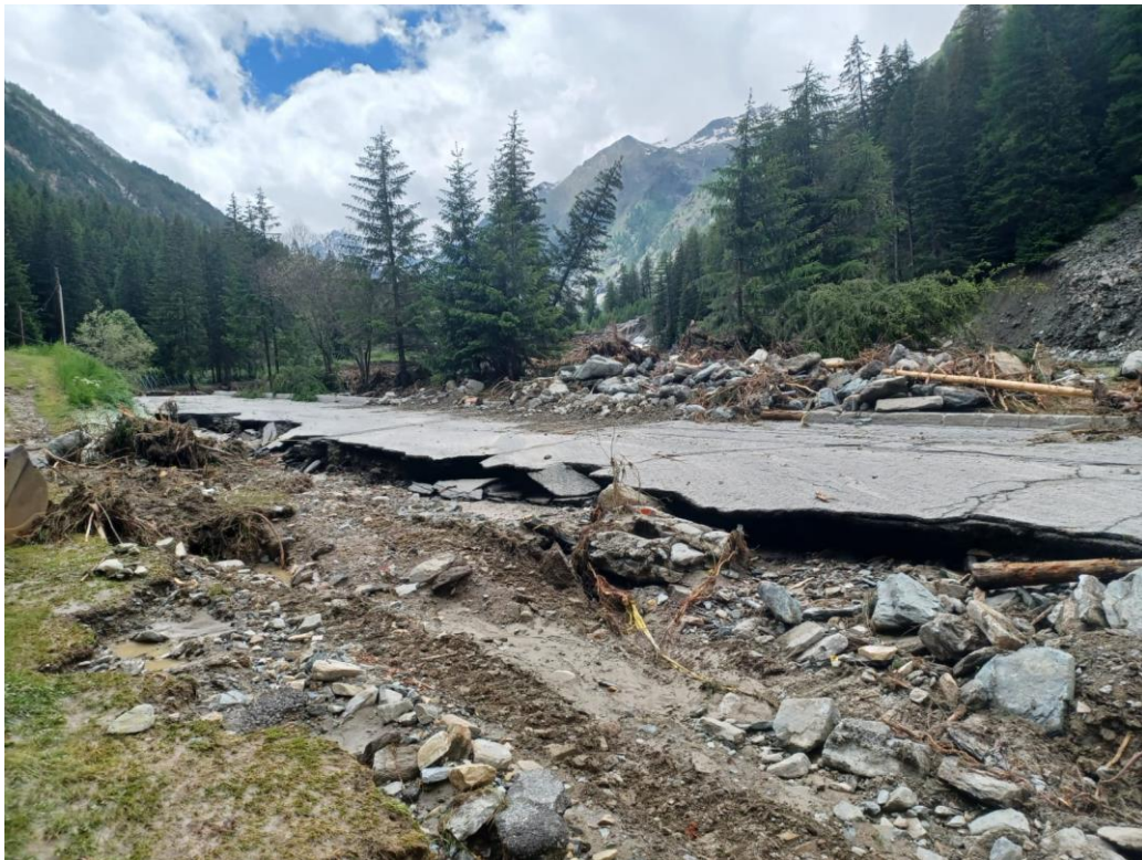
Tratto della strada della Valnontey completamente distrutti dalla piena del torrente Grand-Eyvia.
