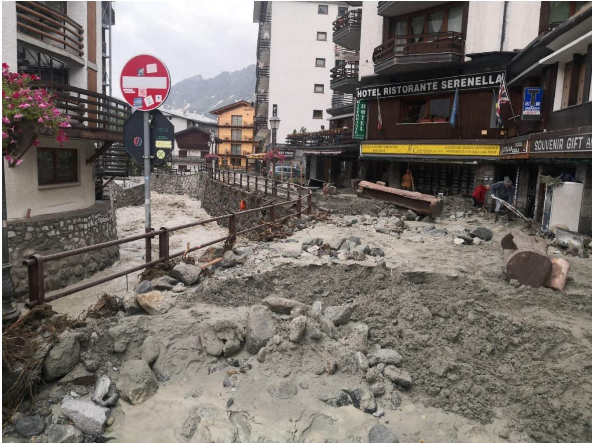
Dettaglio del materiale detritico-fangoso accumulato dal torrente all'interno dell'abitato di Breuil (ID 3805).
