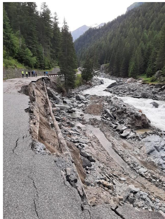
Tratti della strada comunale della Valnontey interessati da profondi fenomeni erosivi che hanno messo a giorno e danneggiato acquedotto e fognatura.
