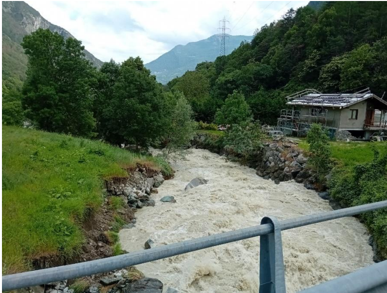
Erosioni lungo le sponde del T. Marmore con asportazione di tratti di scogliera in località Covalou (comune Antey-Saint-André) ID 3759.
