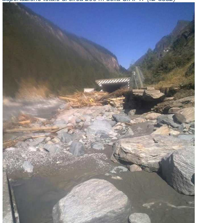
Dettaglio del tratto di strada asportato, visto da monte (ID 3852)
