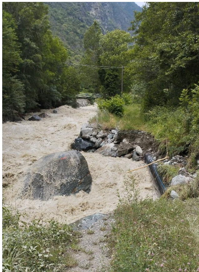
Erosione spondale T. Marmore in località Champlong. (ID 3739).
