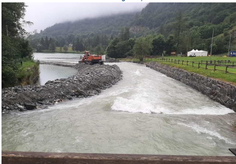
Altra vista. T. Marmore presso la sezione idrometrica di Maen (foto scattata dopo gli interventi di disalveo effettuati in somma urgenza).
