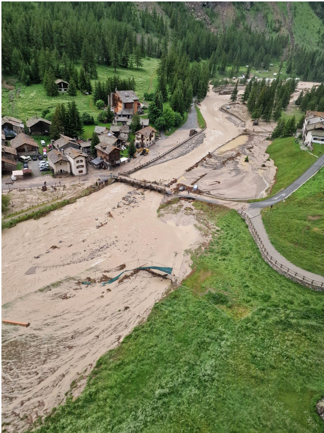
Vista da elicottero dell'abitato di Valnontey allagato dall'omonimo torrente in piena.
