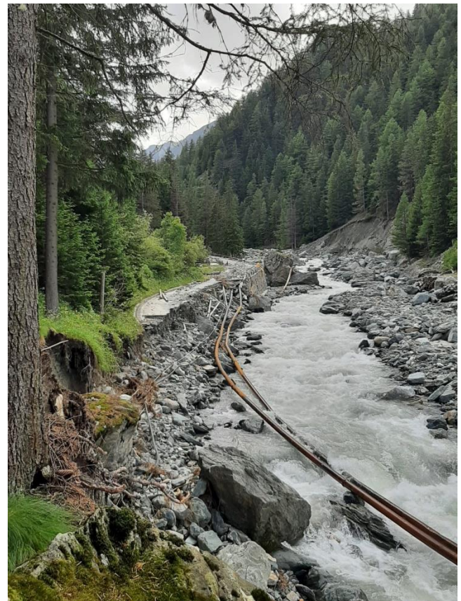
Altri tratti della strada comunale della Valnontey interessati da profondi fenomeni erosivi che hanno messo a giorno e danneggiato acquedotto fognatura e altri sottoservizi.
