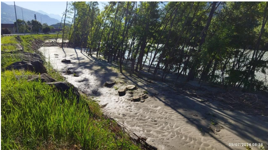
Esondazione della Dora Baltea al confine tra il comune di Brissogne e Pollein (Zona ipermercato Carrefour) (ID 3938).
