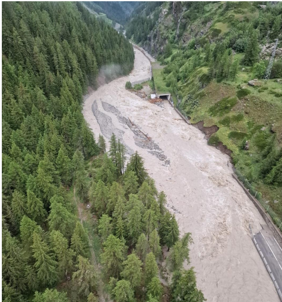
Esondazione ed erosione del T Grand-Eyvia con asportazione totale di circa 200 m della S.R. 47 (ID 3852)
