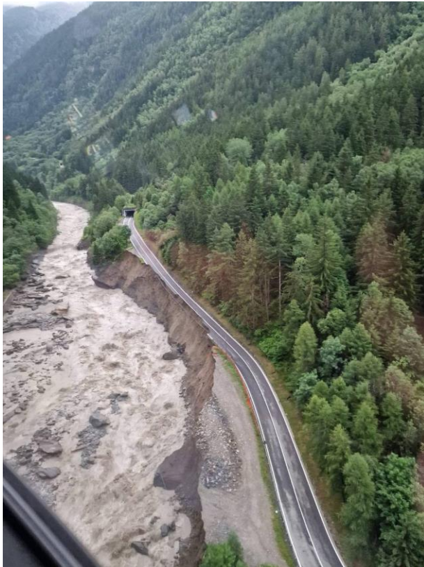
Erosione totale di un tratto della sponda sinistra idr. del T. Grand-Eyvia. S.R. 47 asportata (ID 3722)
