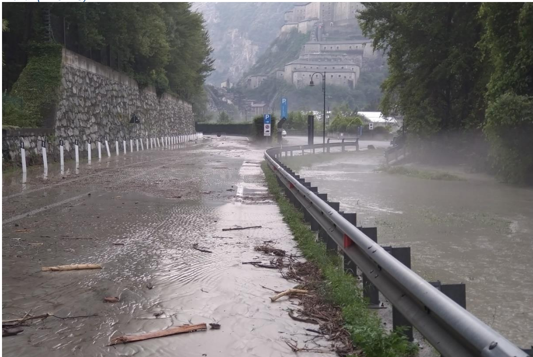
Come la precedente, vista più a monte. La Dora Baltea ha invaso la carreggiata strada statale S.S. 26 km 55 nel comune di Bard (ID 3728).
