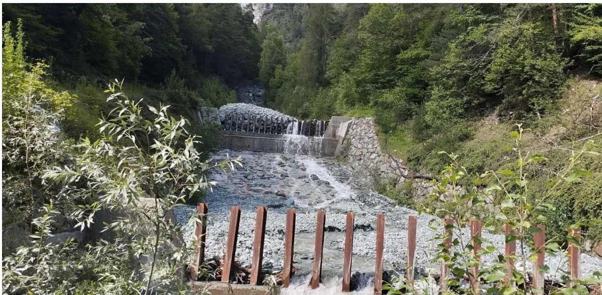
Fenomeno di trasporto di massa lungo il T. Grand Valey. Alcune briglie si presentano colme di materiale (ID 3881).
