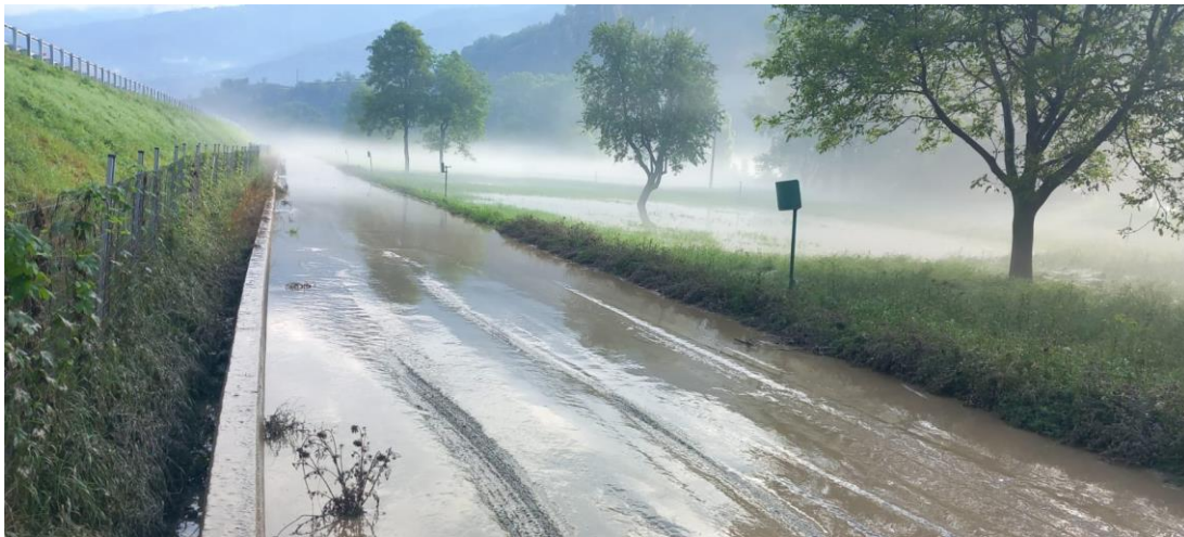
Esondazione Dora nell'rea compresa tra il sottopasso Lorial e la loc. Fabrica nel comune di Verres (ID 3721)
