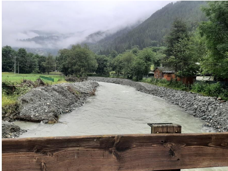
T. Marmore presso la sezione idrometrica di Maen (foto scattata dopo gli interventi di disalveo effettuati in somma urgenza)
