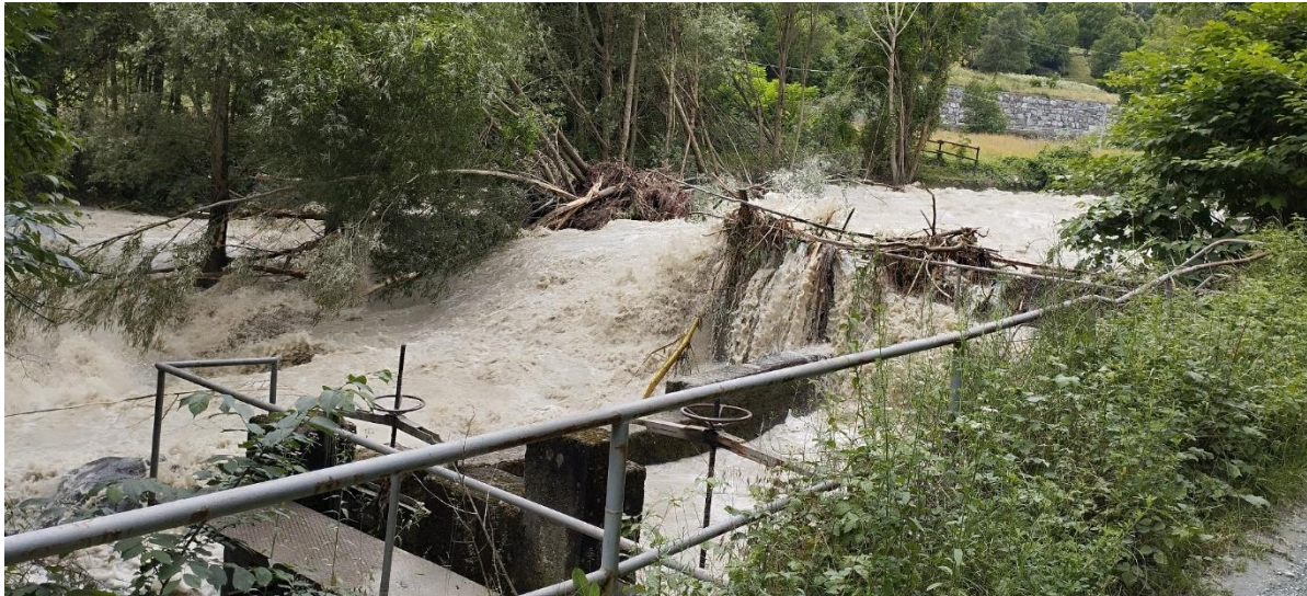
Erosioni e fenomeno di trasporto di materiale solido e tronchi d'albero nei pressi dell'opera di presa (ru du Bourg) sul T. Marmore in località Champlong. (ID 3739).
