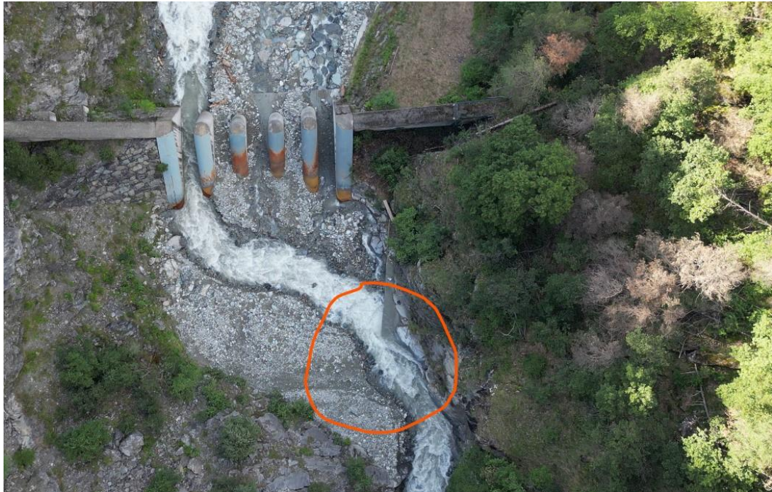
Vista dall'alto delle Briglie colmate dal trasporto solido del torrente Comboé a valle dell'abitato di Pollein. ID 3868
