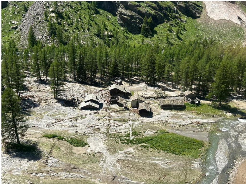
Vista dei fabbricati siti in località Valmianaz gravemente danneggiati dall'esondazione del T. Valnontey
