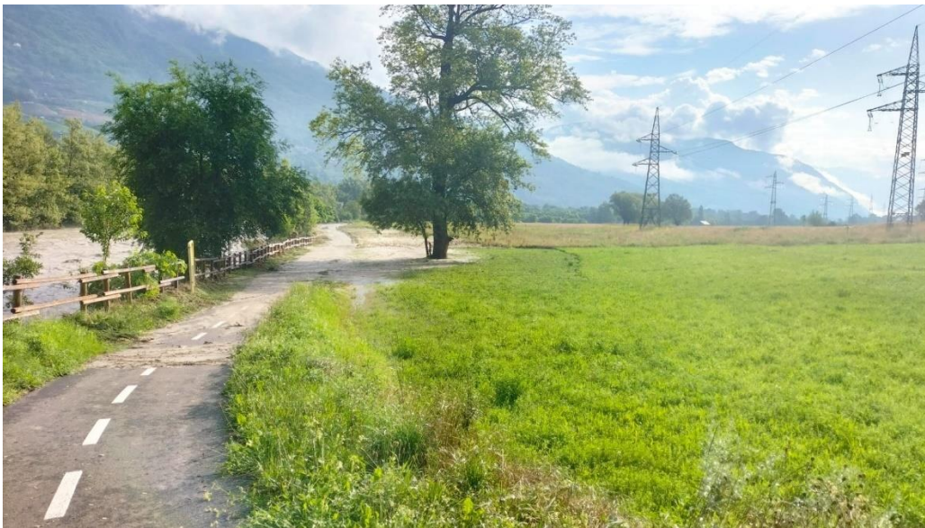
Pista ciclabile in località Tillier. L'esondazione della Dora Baltea ha coinvolto una fascia di circa 10 m di larghezza oltre la pista ciclabile, in corrispondenza di un prato irriguo.
