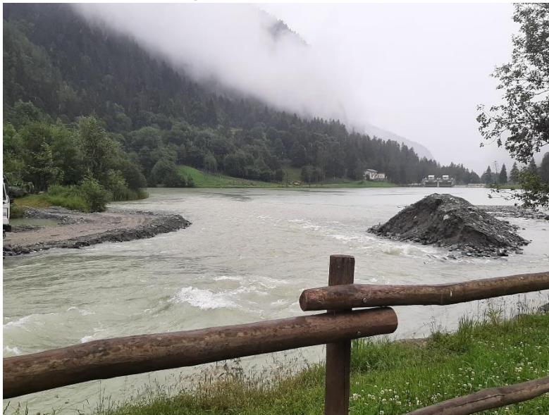
Altra vista. T. Marmore presso la sezione idrometrica di Maen (foto scattata dopo gli interventi di disalveo effettuati in somma urgenza). Sullo sfondo l'invaso di Maen.
