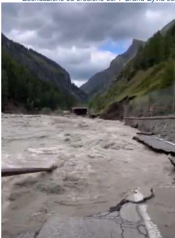
Dettaglio del tratto di strada asportato, visto da monte (ID 3852)
