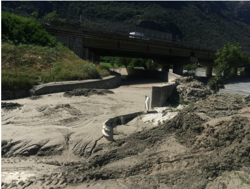
Esondazione Dora nell'rea compresa tra il sottopasso Lorial e la loc. Fabrica nel comune di Verres (ID 3921)
