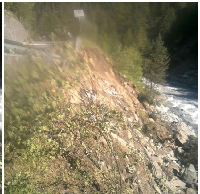
Dettaglio della scarpata interessata dall'erosione del T. Grand-Eyvia (ID 3852)
