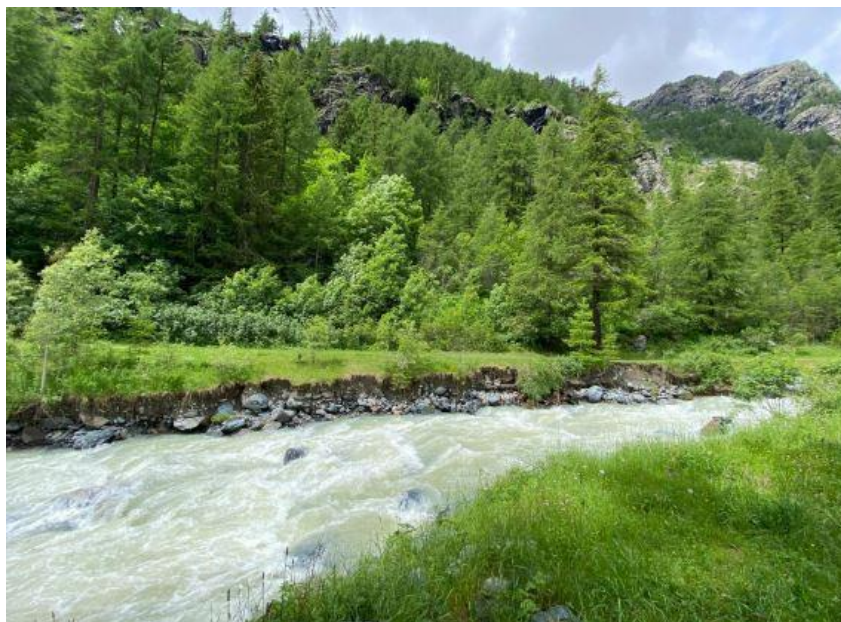
Fenomeni erosivi lungo il T.Lys , con la messa a nudo della tubazione dell'acquedotto comunale. Gressoney-La-Trinité. ID 3883 .
