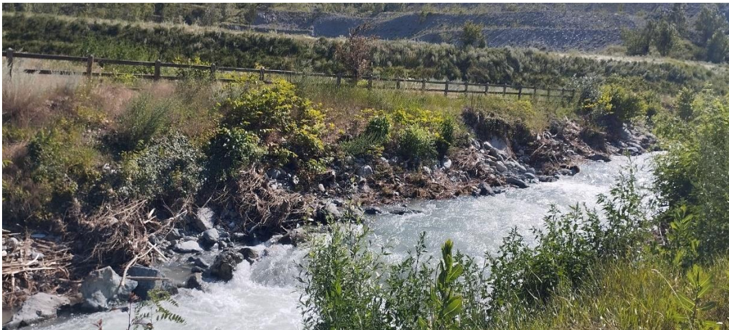
Erosione spondale in località Lago Movida (ID 3957)
