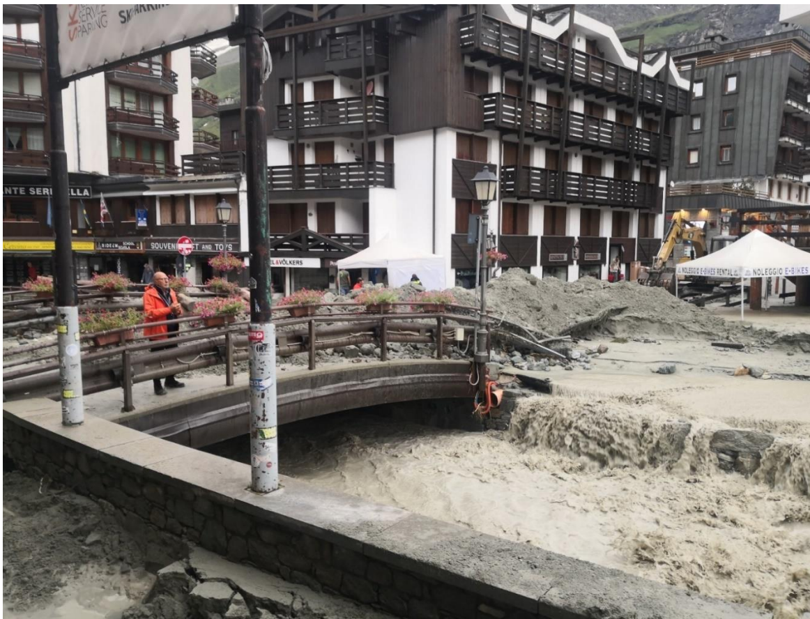
T. Cervino in piena, deposito di materiale solido e operazioni di ripristino del deflusso nell'alveo canalizzato in loc. Breuil Cervinia (3805).
