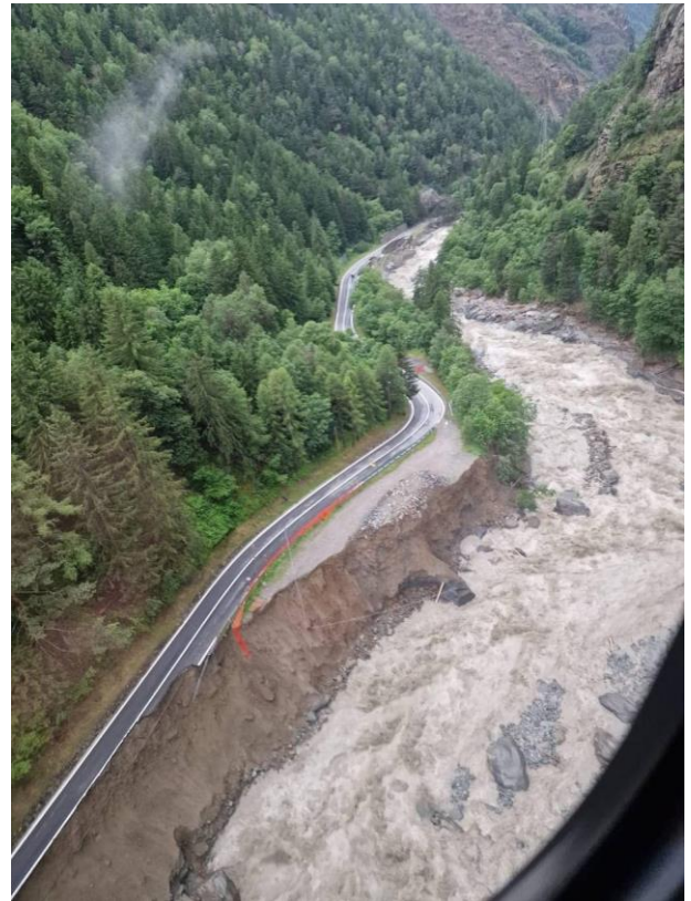
Erosione totale di un tratto della sponda sinistra idr. del T. Grand-Eyvia. S.R. 47 asportata (ID 3722)
