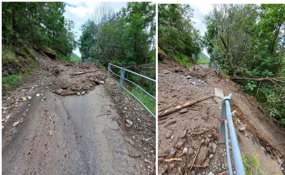
Colata detritica lungo la strada che sale nel vallone di Verdone (ID 3727).
