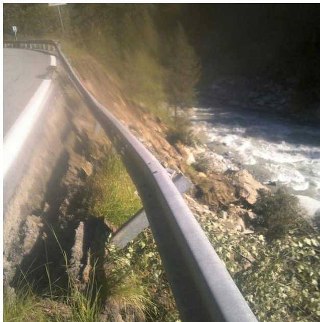
Dettaglio della scarpata interessata dall'erosione del T. Grand-Eyvia (ID 3852)
