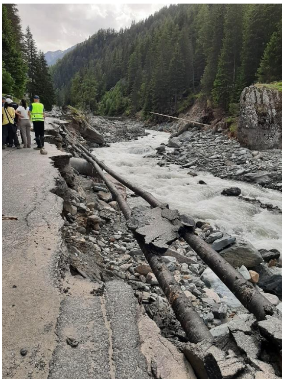
Tratti della strada comunale della Valnontey interessati da profondi fenomeni erosivi che hanno messo a giorno e danneggiato acquedotto e fognatura.
